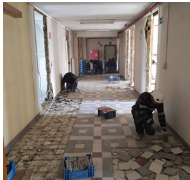
»Odstranjevanje ploščic pri rušenju«. Vir: Rotordc www.rotordc.com
